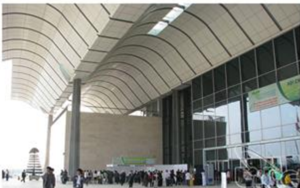
KHU NGOÀI TRỜI CÓ MÁI CHE (S) / ROOFED OUTDOOR AREA (S)
